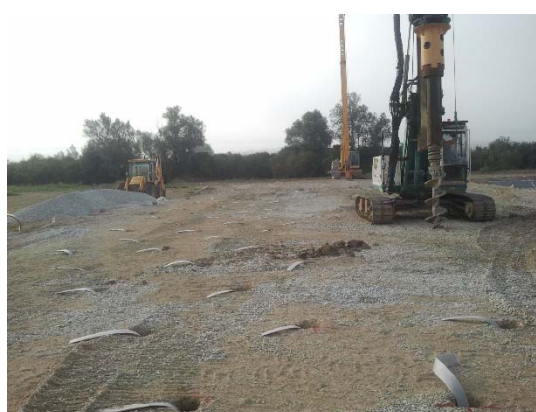
Izvedba vertikalnih drenova
