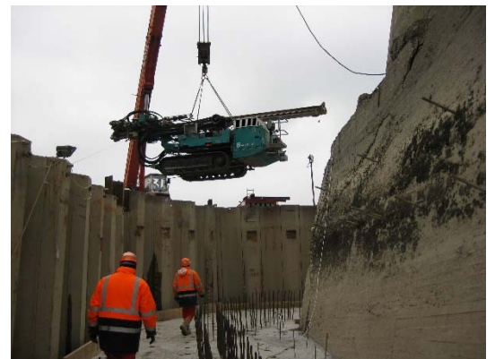
Prebacivanje bušilice na temelj stupa
