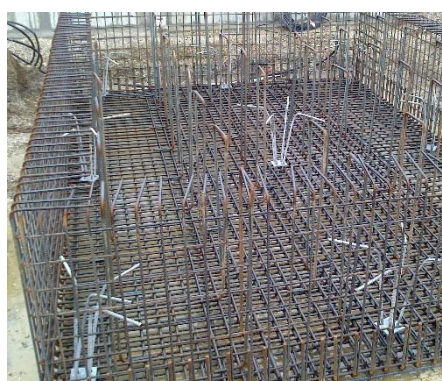
Armatura stupova i temelja
