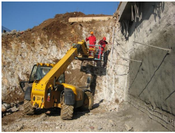
Nanošenje mlaznog betona na pilotsku stijenu
