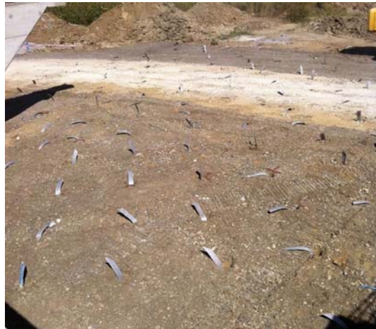
Polje izvedenih vertikalnih drenova
