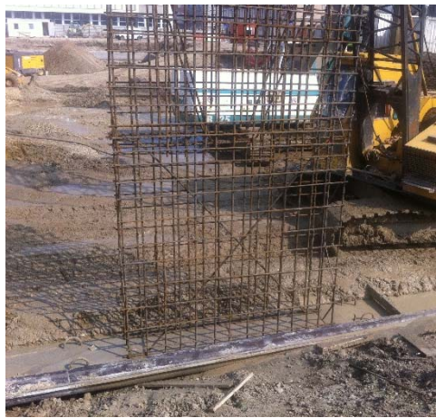
← Spuštanje armature u rov dijafragme
