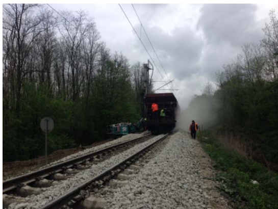
Izvedba radova uz odvijanje prometa prugom
