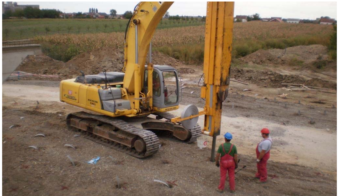
Izvođenje vertikalnih drenova
