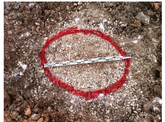
Izvedeni šljunčani stup promjera 100 cm
