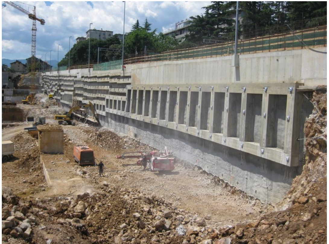
Zaštitna konstrukcija uz glavnu prometnicu u Rijeci
