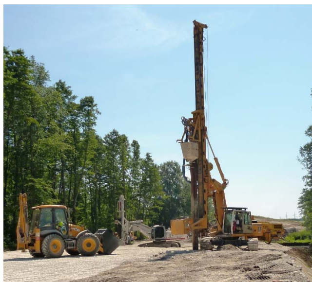
Izvedba šljunčanih stupova i impulzivno zbijanje tla
