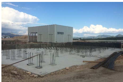
Glave zabijenih pilota i podložni beton
