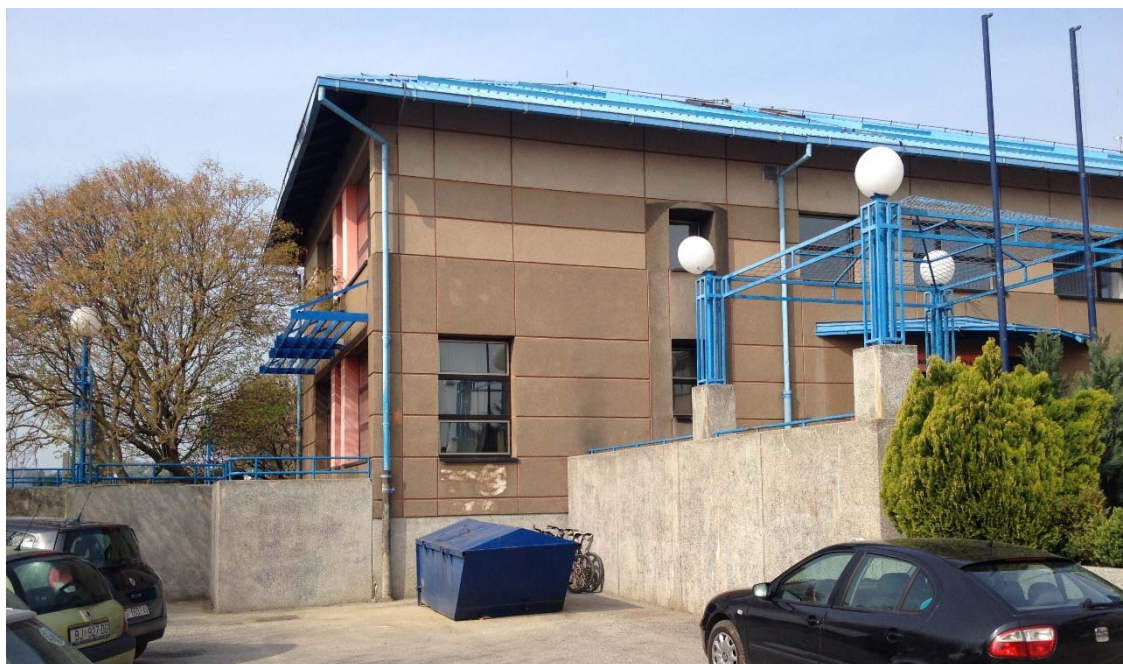
Južno krilo zgrade škole sanirano mikropilotima
