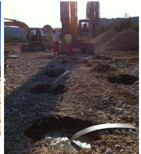
Vertikalni drenovi u funkciji
