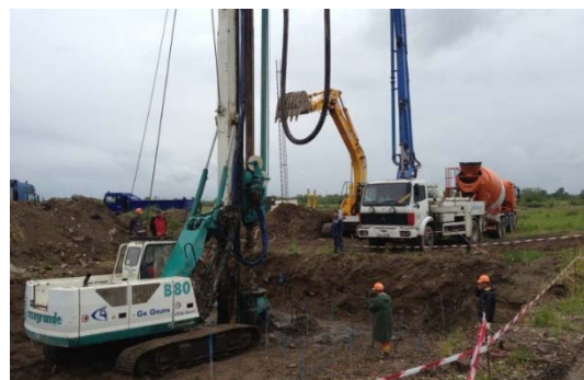
Izvedba CFA pilota
