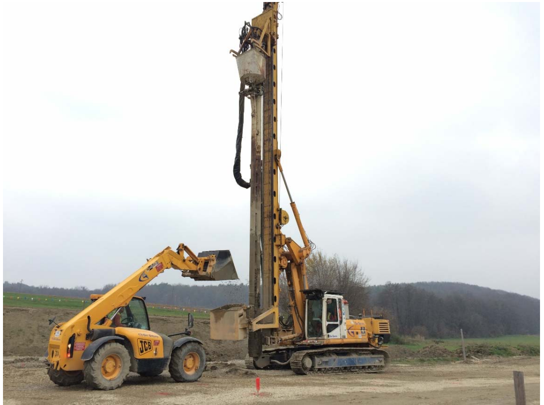
Izvedba šljunčanih stupova
