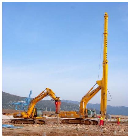
Utiskivanje vertikalnih drenova
