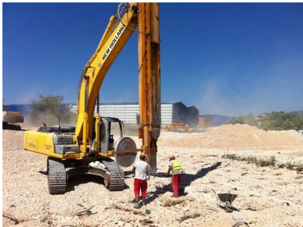
Ugradnja vertikalnih drenova
