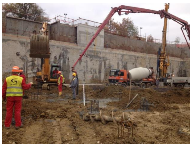
Betoniranje pilota pomoću beton pumpe
