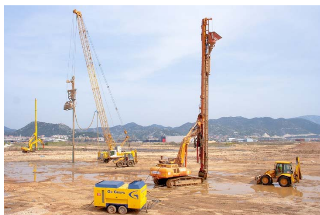
Izvedba šljunčanih stupova i vertikalnih drenova
