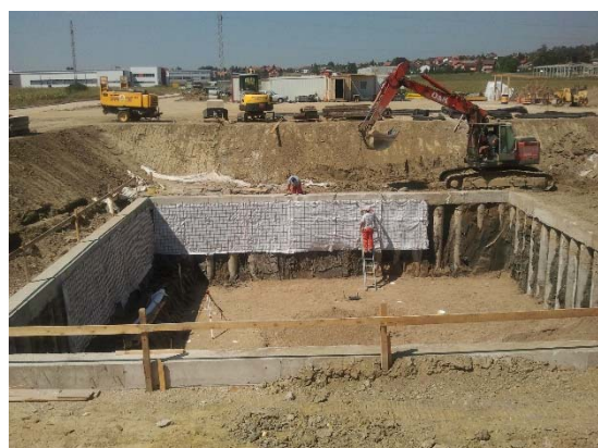
Polaganje armaturne mreže i geotekstila
