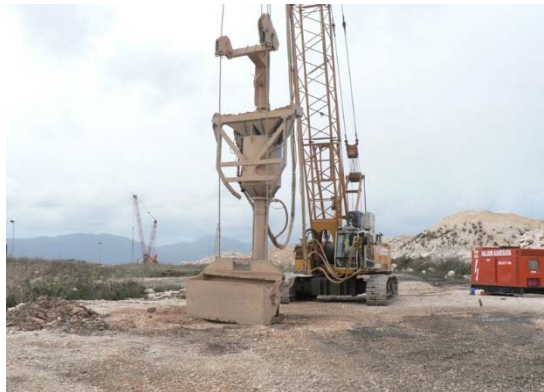
Izvedba šljunčanih stupova
