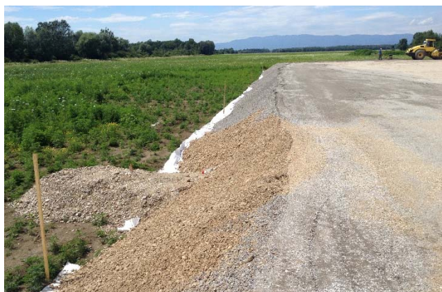
Nasip predopterećenja i ušće inklinometra
