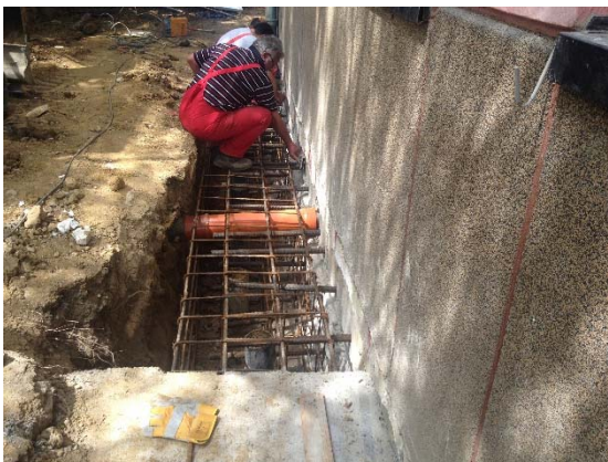
Postavljanje armature naglavne grede
