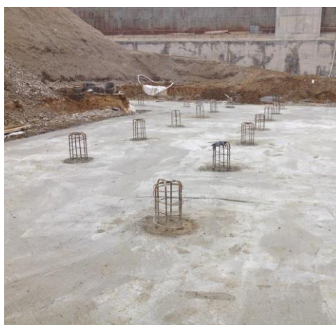
← Postavljeni podložni beton nakon izvođenja pilota
