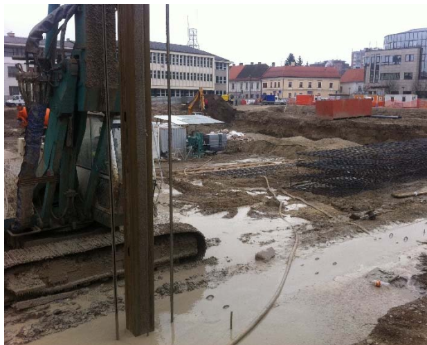
Iskop rova dijafragme pod zaštitom bentonitne isplake
