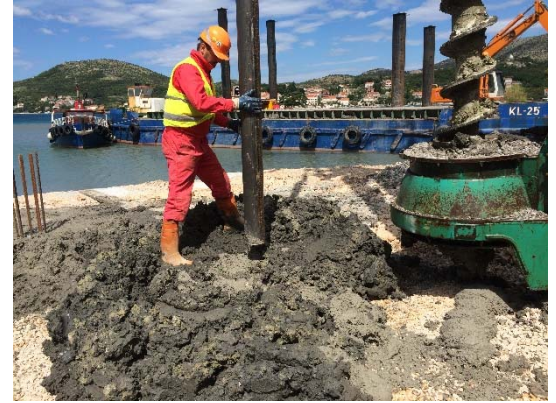
Ugradnja čelične cijevi u svježi beton
