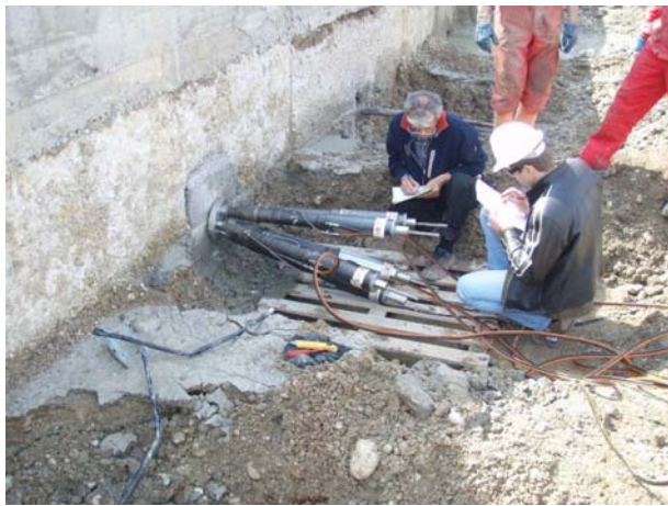
Ispitivanje nosivosti sidara
