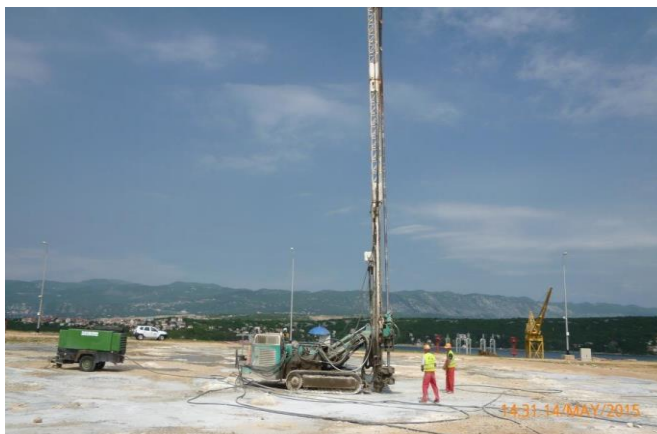
← Pozicioniranje stroja za mlazno injektiranje
