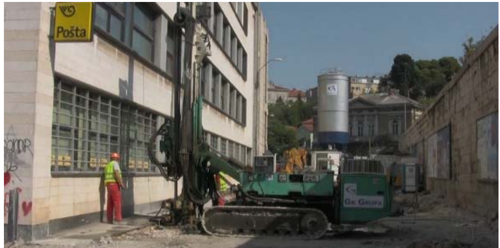
Izvedba mlaznog injektiranja
