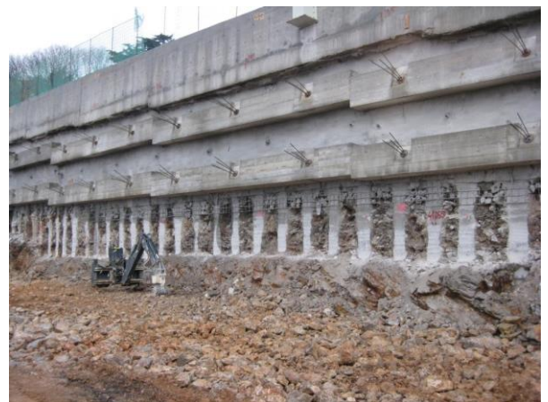
Priprema pilotske stijene za izvedbu sidara i mlaznog betona
