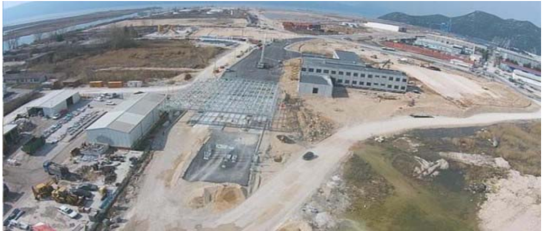
Gradnja novog ulaza u luku
