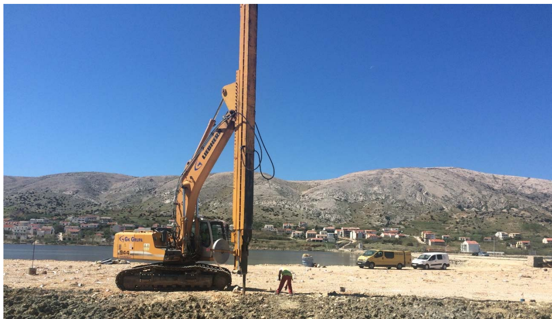
Izvedba prefabriciranih vertikalnih drenova
