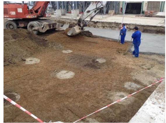
Iskop za temeljenje i polaganje podložnog betona
