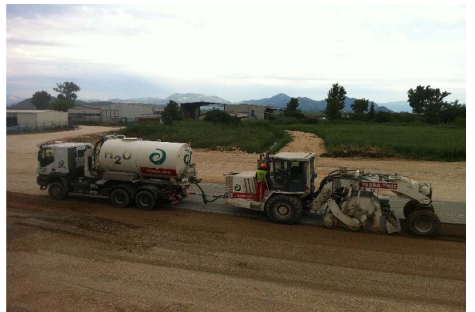
Izvedba cementne stabilizacije
