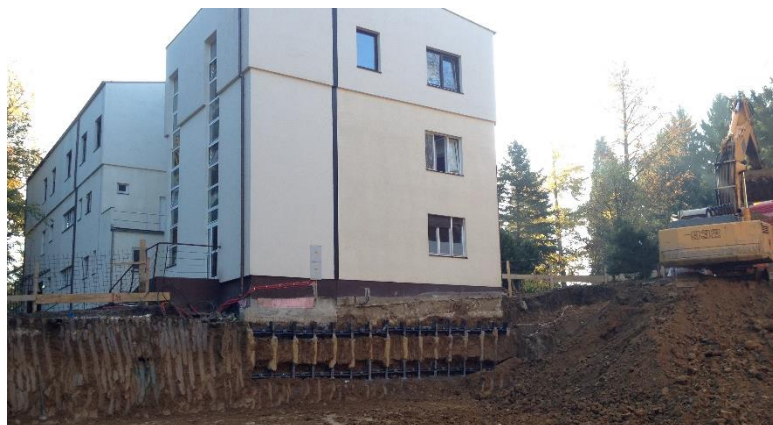
Zaštitna konstrukcija uz odjel II
