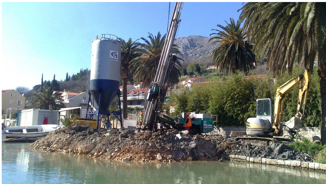
Izvođenje radova uz obalu rijeke Ombla
