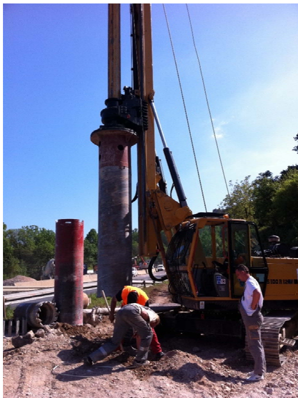
Bušenje za izvedbu pilota
