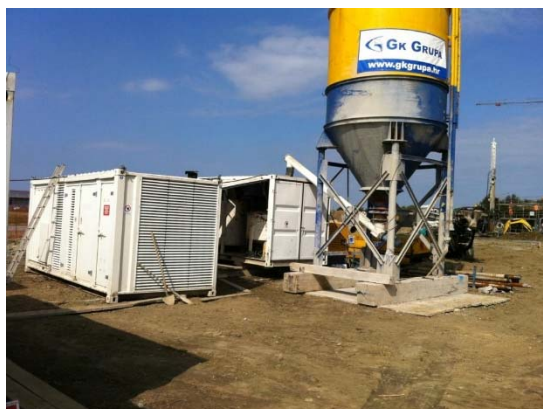
Visoko tlačna pumpa, mješalica i silos za cement
