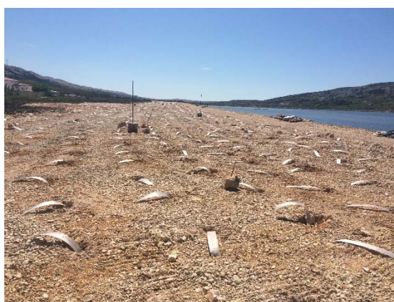
Polje izvedenih vertikalnih drenova
