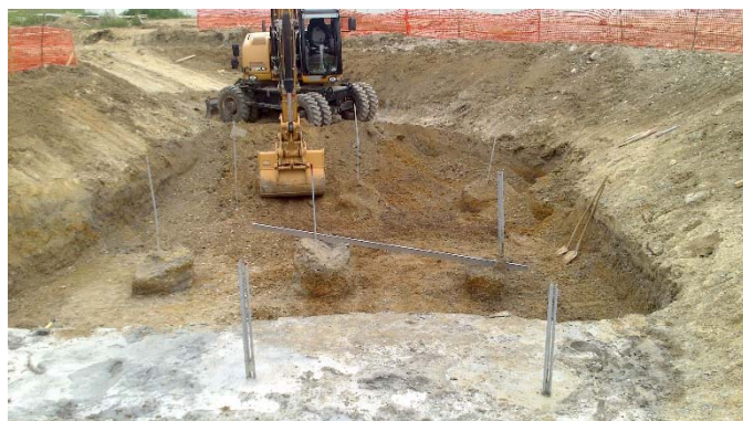
Priprema glave stupova za podložni beton
