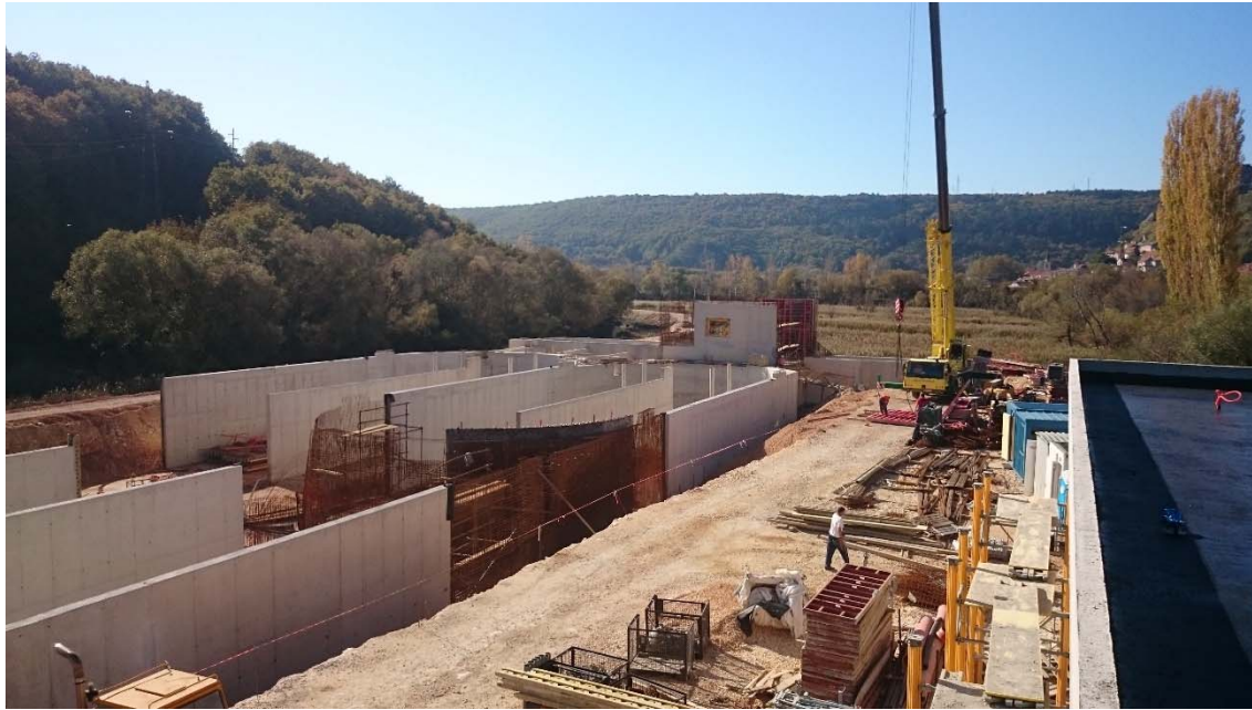
← Betoniranje bioreaktora i naknadnih taložnika
