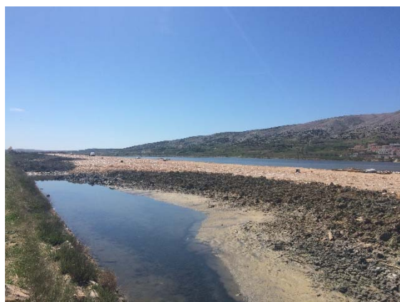
Nasipavanje mora za gradnju nove ceste
