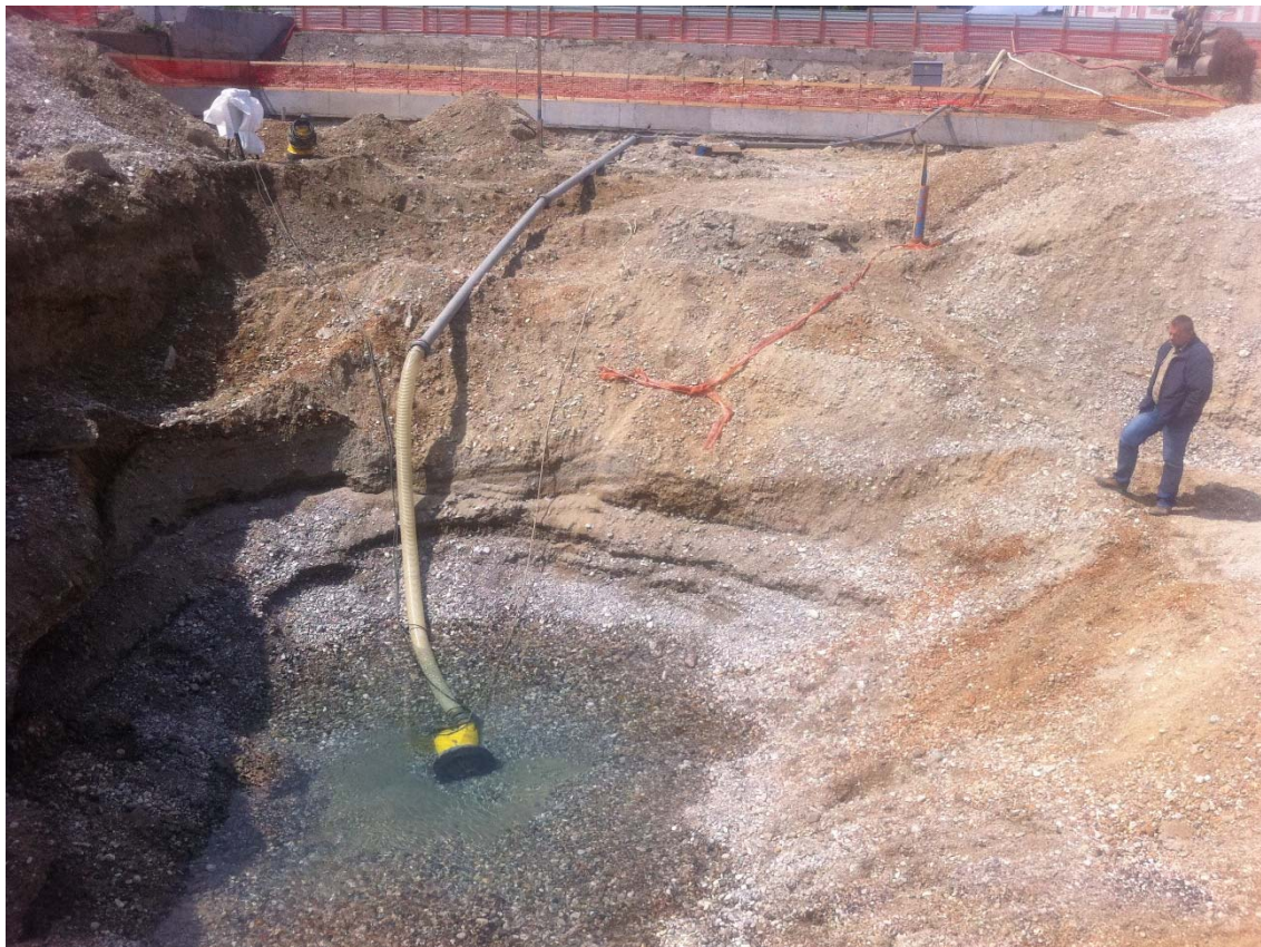
← Razina podzemne vode spuštена na kotu iskopa
