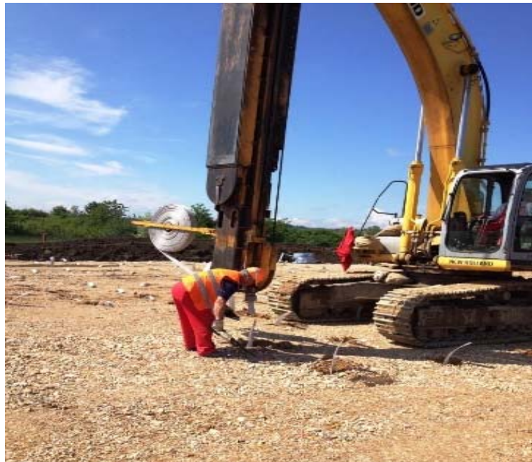
Pozicija izvedenih vertikalnih drenova
