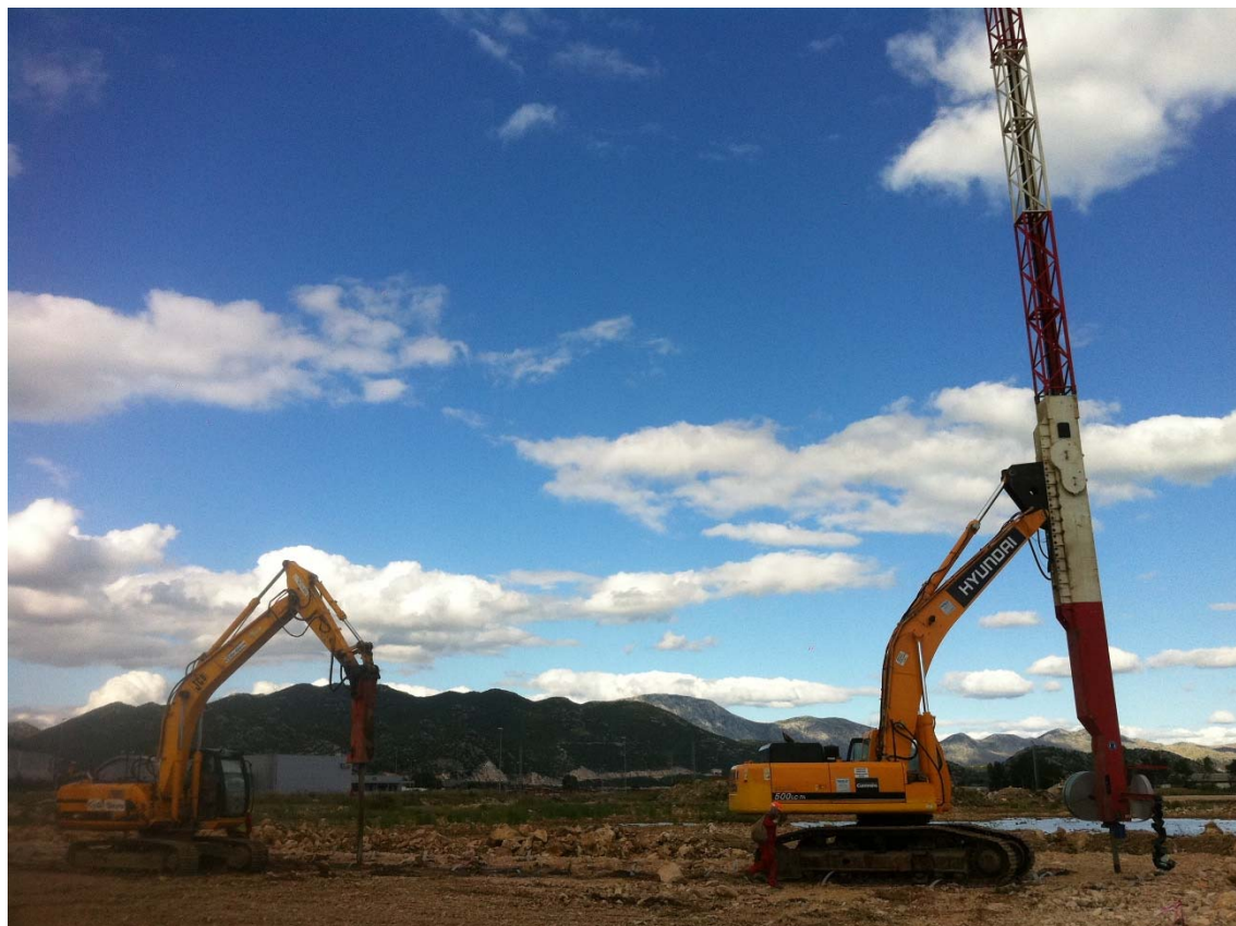
← Probijanje starog nasipa hidrauličkim čekićem
