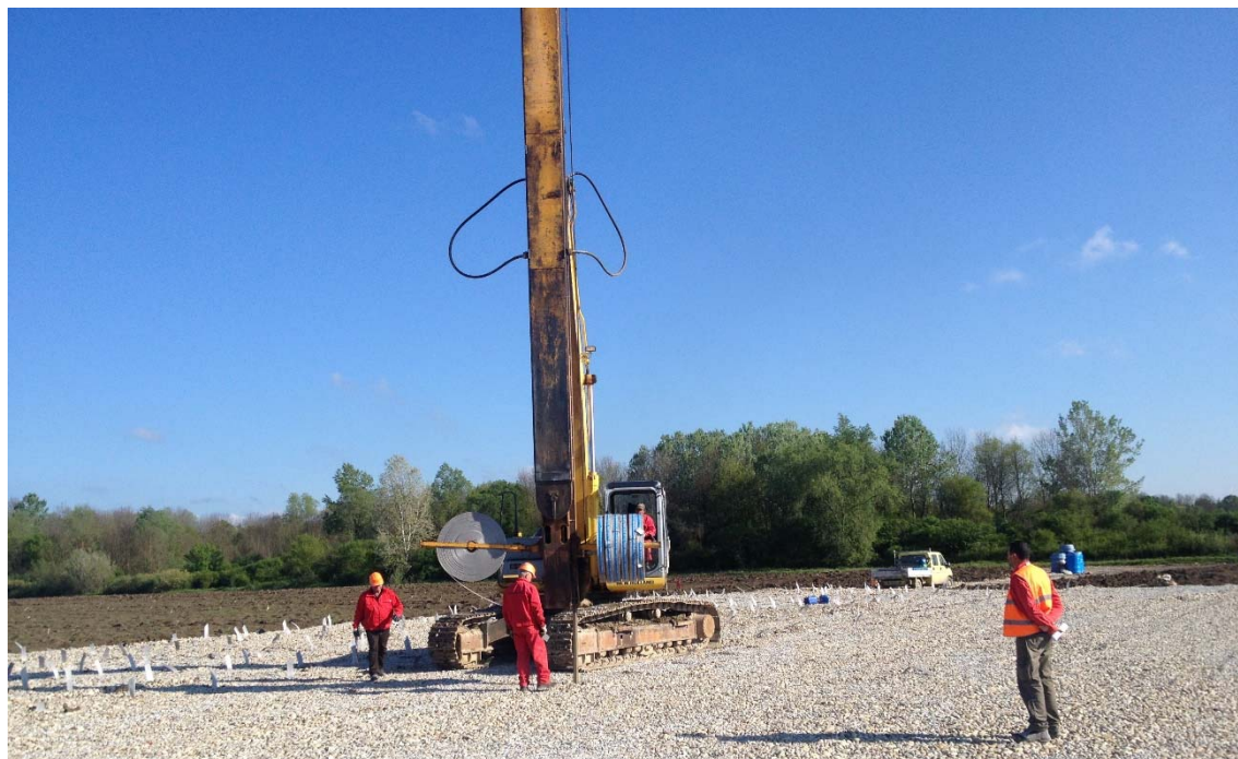
Izvedba prefabriciranih vertikalnih drenova
