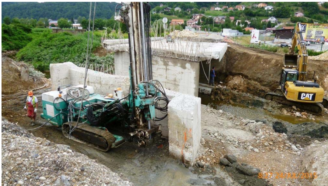
Mlazno injektiranje neposredno uz temeljnu stopu upornjaka
