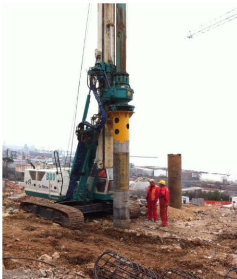
Bušenje pilota sa zaštitnom kolonom
