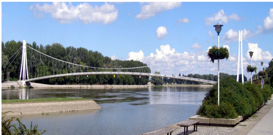
Izgrađen most preko rijeke Drave u Osijeku
