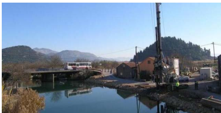
Izvedba AB pilota promjera 800 mm
