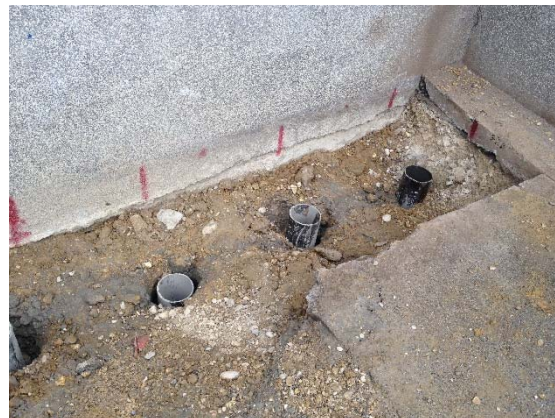
Mikropiloti izvedeni uz temelj zgrade
