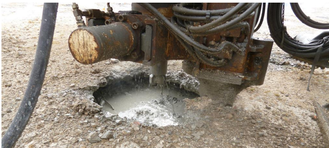
← Završetak mlaznog injektiranja
