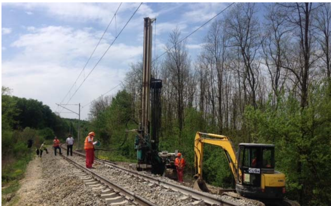
Mlazno injektiranje ispod tijela nasipa pruge
