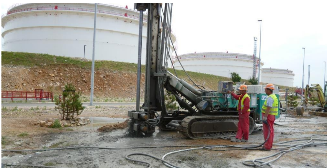
← Izvedba mlazno injektiranog stupa
