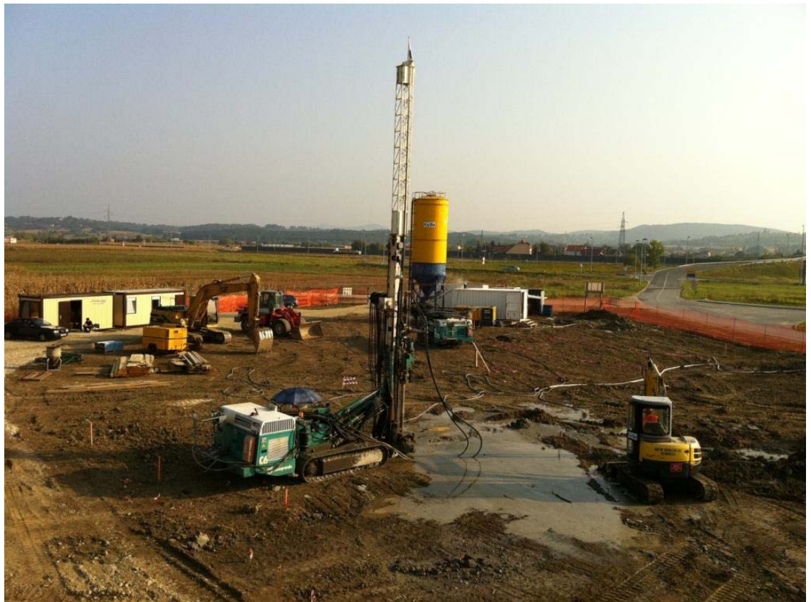
Početak radova na mlaznom injektiranju
