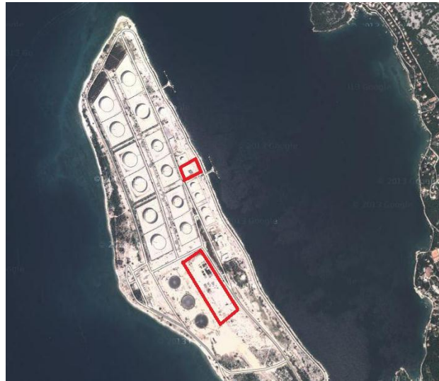
Lokacija izvođenja radova, rt Tenka
