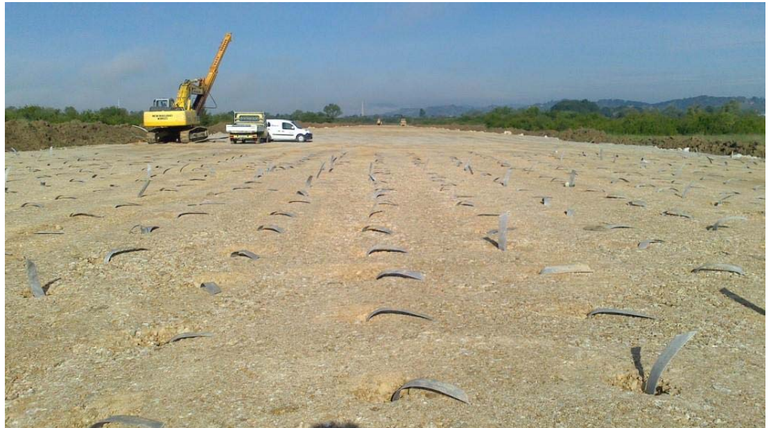
Pozicija izvedenih vertikalnih drenova
