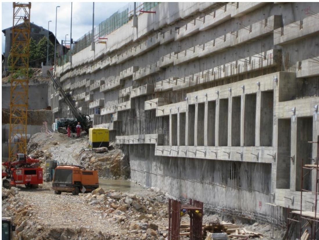
← Ojačanje tla injektiranjem iza zaštitne konstrukcije
