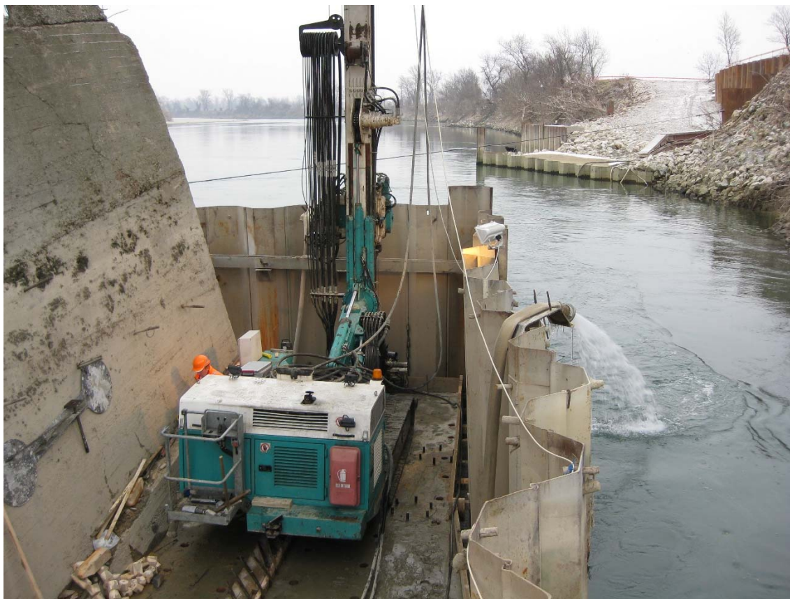
← Rad na mlaznom injektiranju u izuzetno skučenom prostoru
