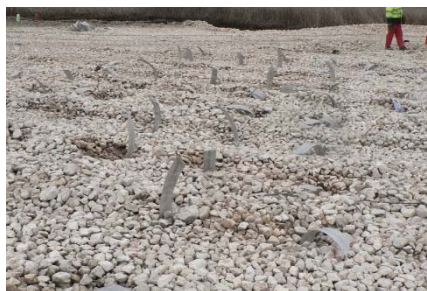
Polje izvedenih vertikalnih drenova
