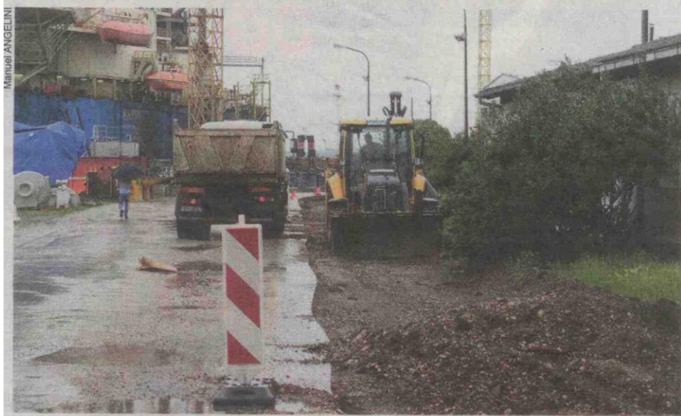
Tek izgradnjom dionice unutar Uljanika završit će se cijeli obalni kolektor
