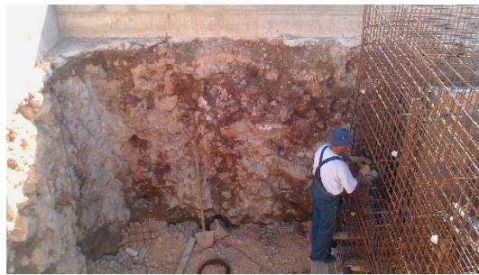
Betonierarbeiten im trockenen
