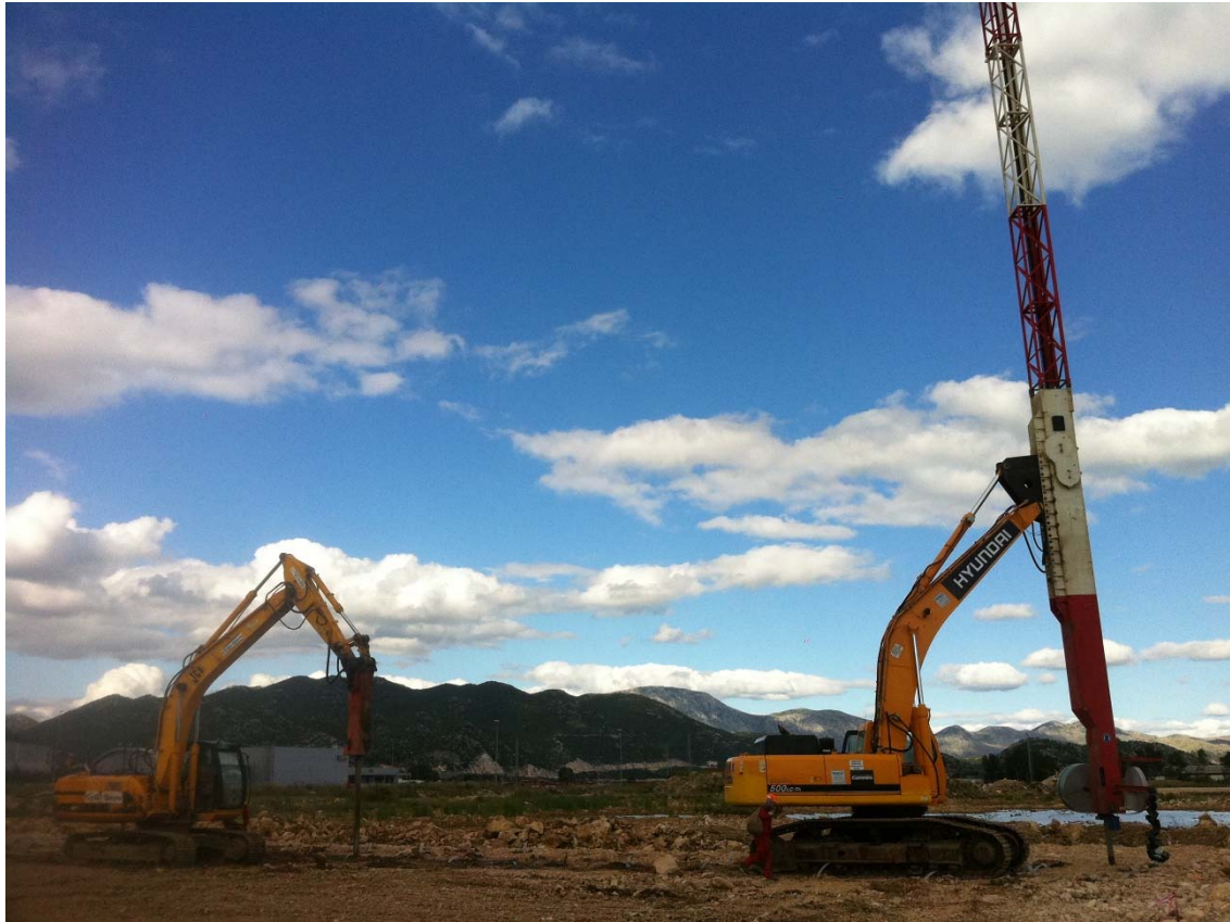
← Durchhörtern der festen Anschüttung mit Hydraulikhammer
