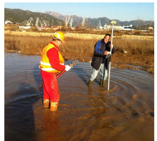
Vermessung und Aussteckung der Punkte
