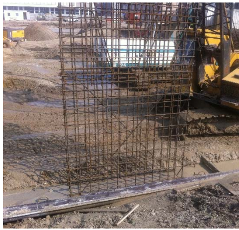
← Bewehrungseinbau Schlitzwand
