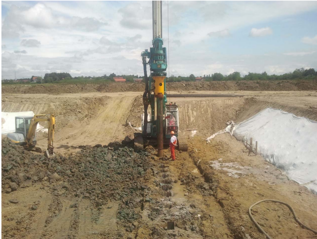
Ausführung Großbohrpfähle
