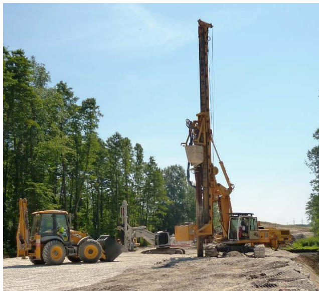
Rüttelstopfverdichtung und Impulsverdichtung
