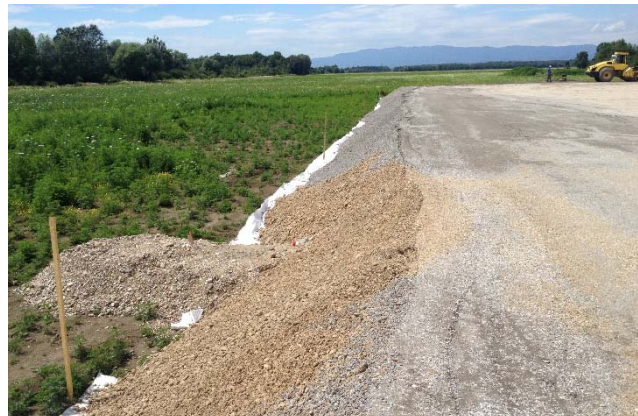
Überlastschüttung
