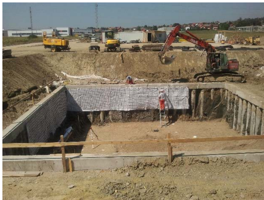
Verlegung Bewehrungsnetz und Geotextil
