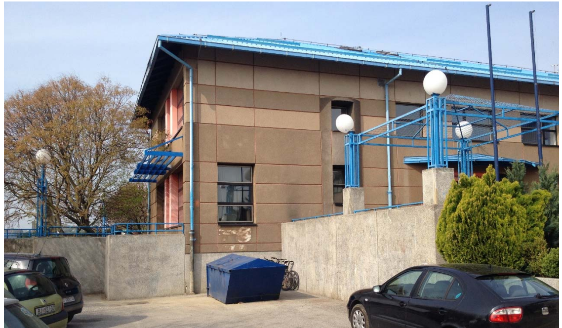
Südlicher Flügel der Schule saniert mit Kleinbohrpfählen
