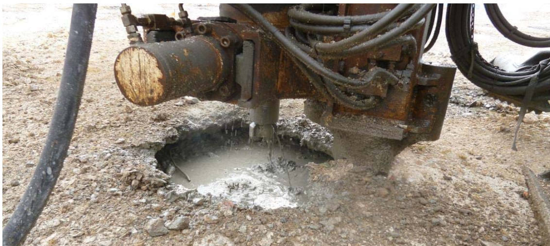
← Fertigstellung einer Jet Grouting Säule
