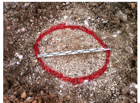
Schotterssäule im Durchmesser 100 cm
