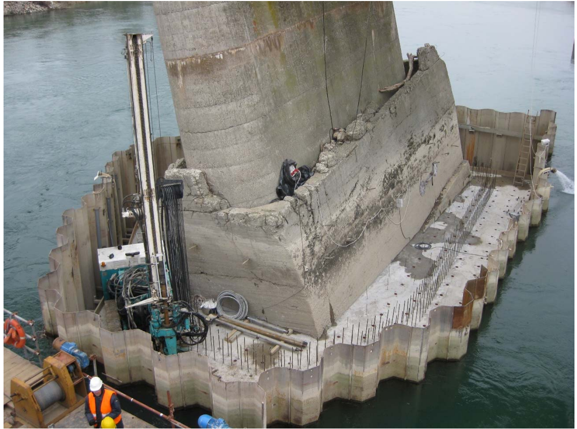
Fundamentverstärkung Brückenpfeiler mit Jet Grouting
