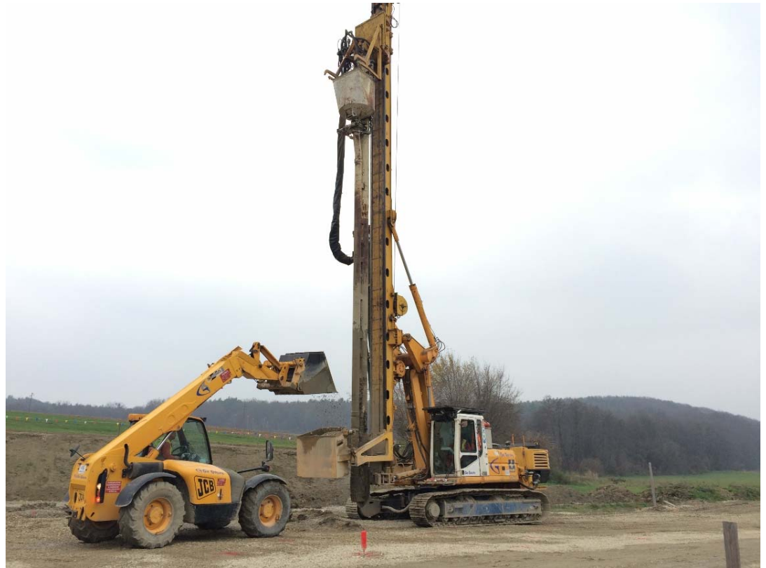
Ausführung der Schotterssäulen
