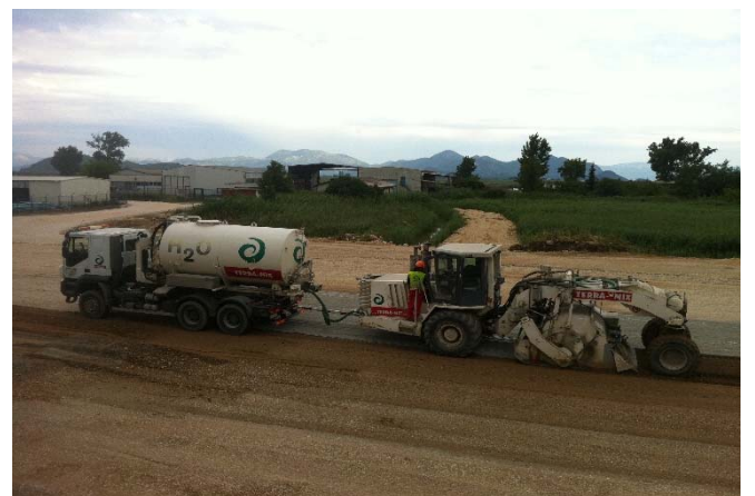
Zementstabilisierung
