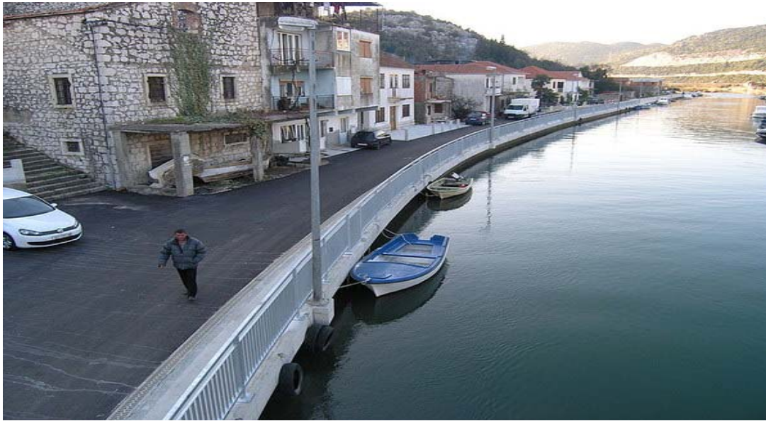
Linke Uferbefestigung des Flusses Crna Rijeka
