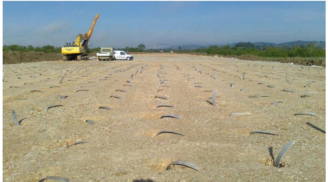
Baufeld mit Streifendrain
