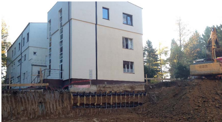
Baugrubensicherung Abteilung II
