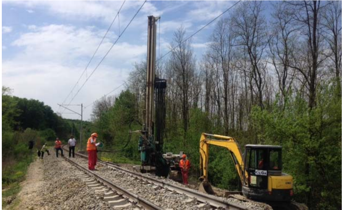
Jet Grouting unterhalb des Eisenbahndamms
