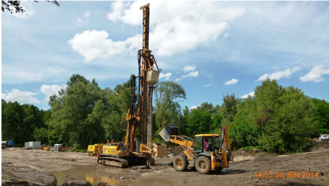
Befüllung des Korbs mit Kies
