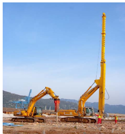
Vertikaldrains
