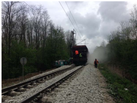
Ausführung während des Verkehrsbetriebs
