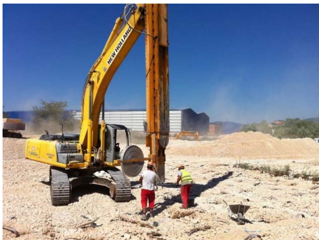
Einbau Vertikaldrains
