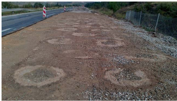
Vorbereitung der Bettung
