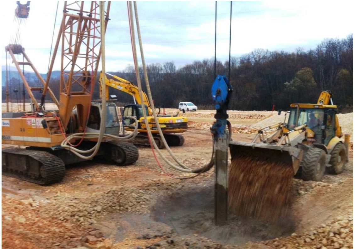
Trichteraufbau während der Tiefenverdichtung
