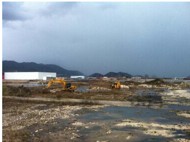
Vorbereitung des Arbeitsplanums
