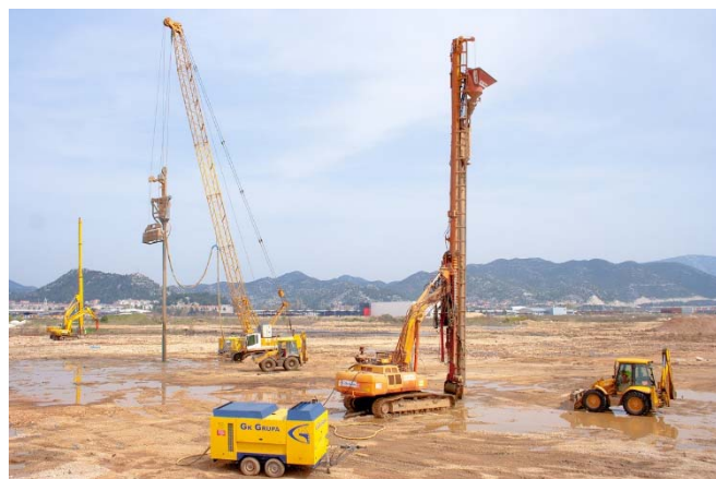
Ausführung Schottersäulen und Vertikaldrains
