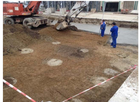
Aushub zum Verlegen des Magerbetons
