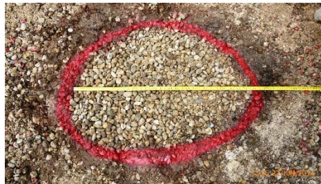
Kontrolle des Säulendurchmessers
