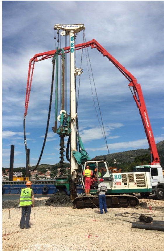
Bohren mit Endlosschnecke
