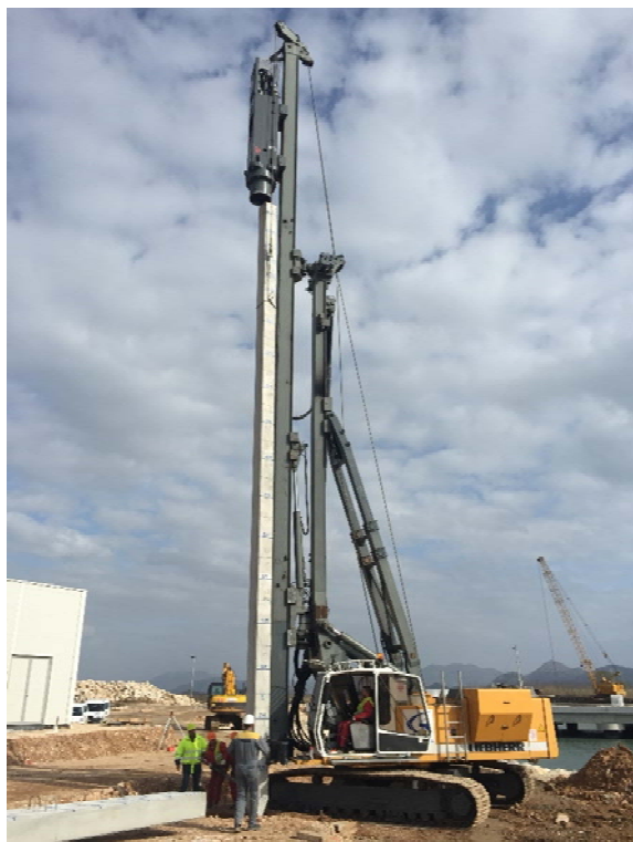
Vorbereitung der Rammeinheit
