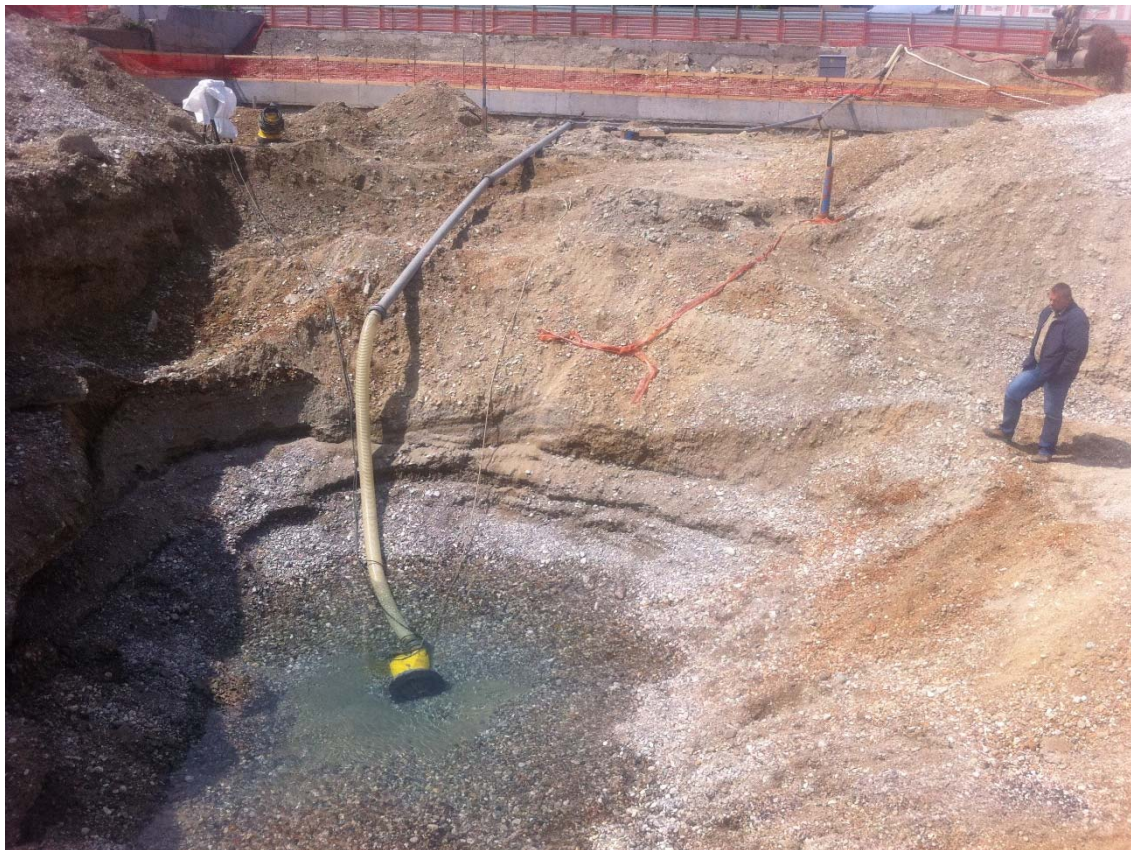
← Grundwasserspiegel abgesenkt auf Aushubhöhe
