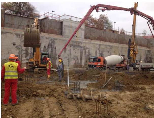
Betonierung der Bohrpfähle
