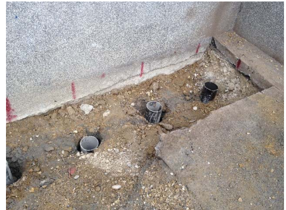
Mikropfähle neben dem Fundament
