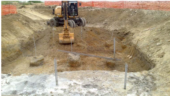
Vorbereitung der Säulenköpfe
