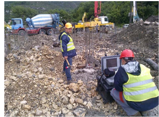
Integritätsprüfung von fertigen Pfählen
