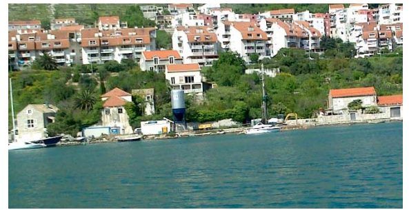
Ansicht von der anderen Seite des Flusses
