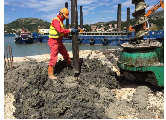
Einbau eines Stahlrohrs in frischen Beton
