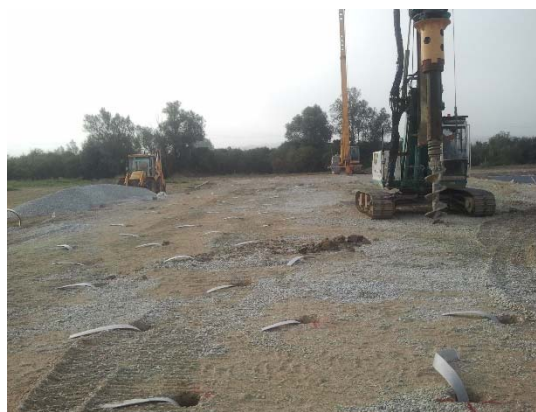
Ausführung Vertikaldrains
