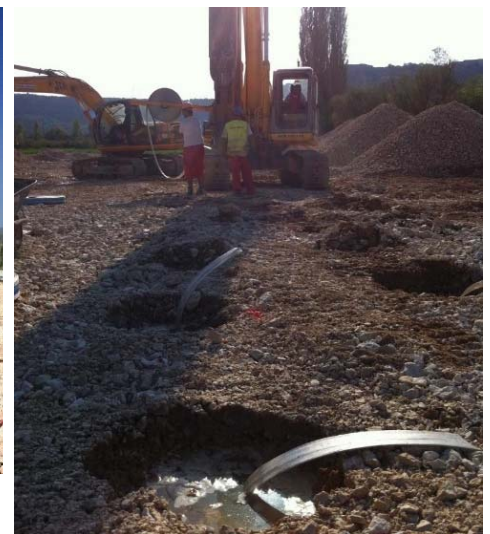
Vertikaldrains in Funktion
