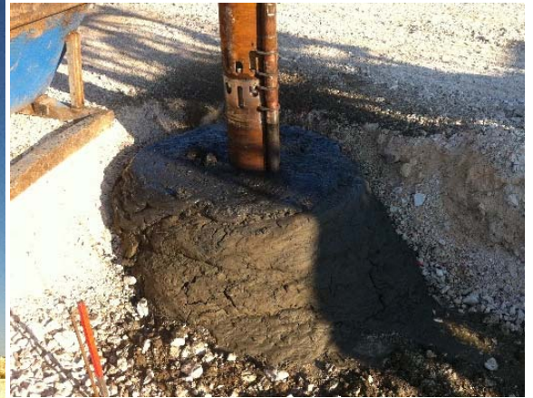
Detail der Ausführung einer Schottersäule
