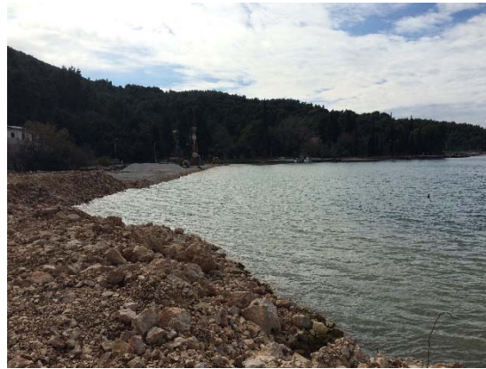
Ausführung der Arbeiten
