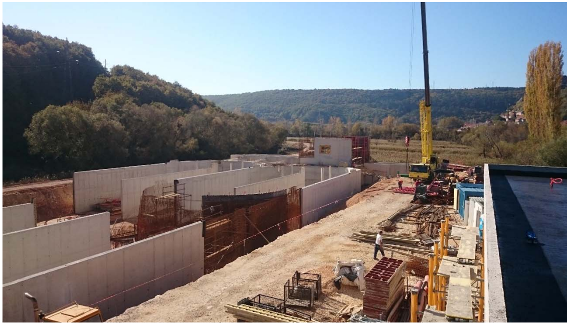
← Betonierarbeiten Bioreaktor und Nachklärbecken
