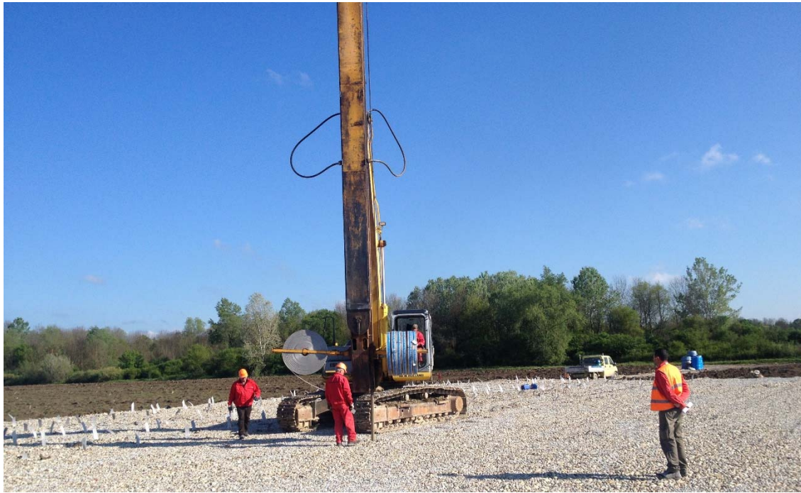
Ausführung vorgefertigter vertikaler Streifendrains
