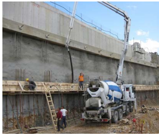
← Betonierung Balkenrost
