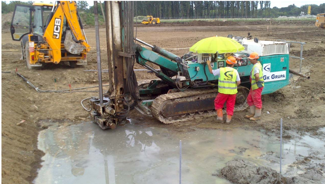
Jet Grouting als Gründungssäulen
