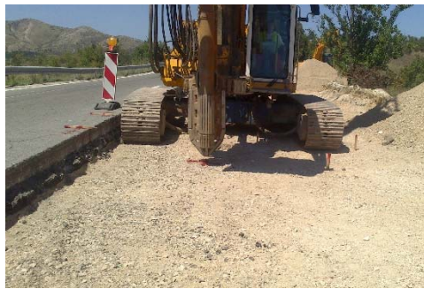
Arbeit bei laufendem Verkehr
