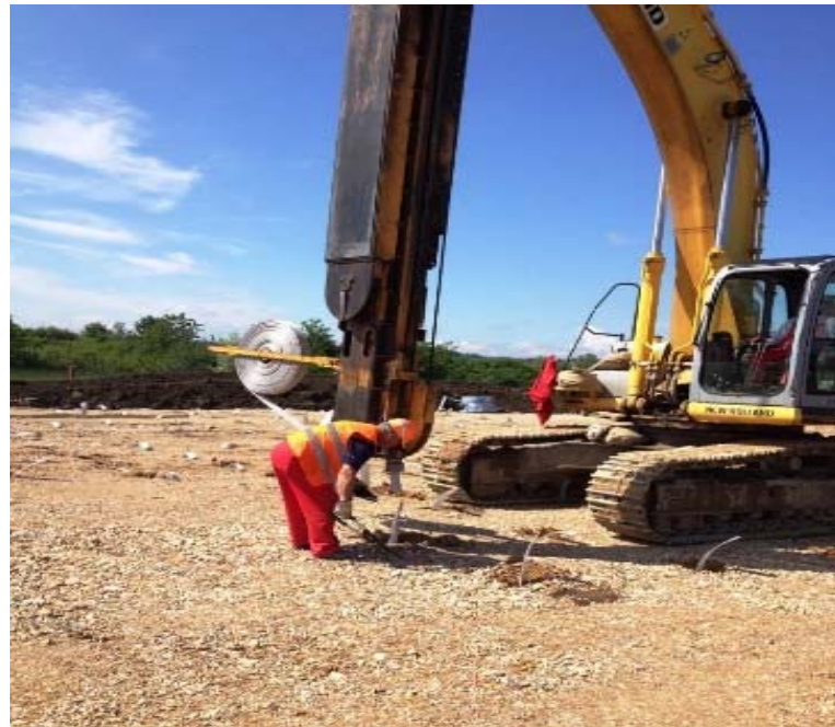
Baufeld mit Streifendrain
