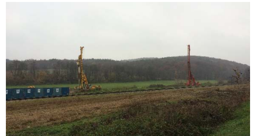
Zwei Geräte im Einsatz
