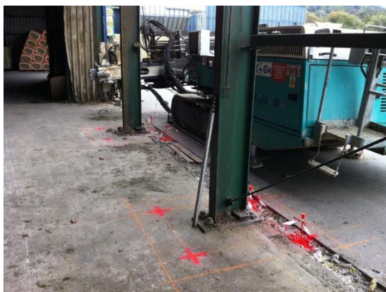
Ausgesteckte Bohrpunkte
