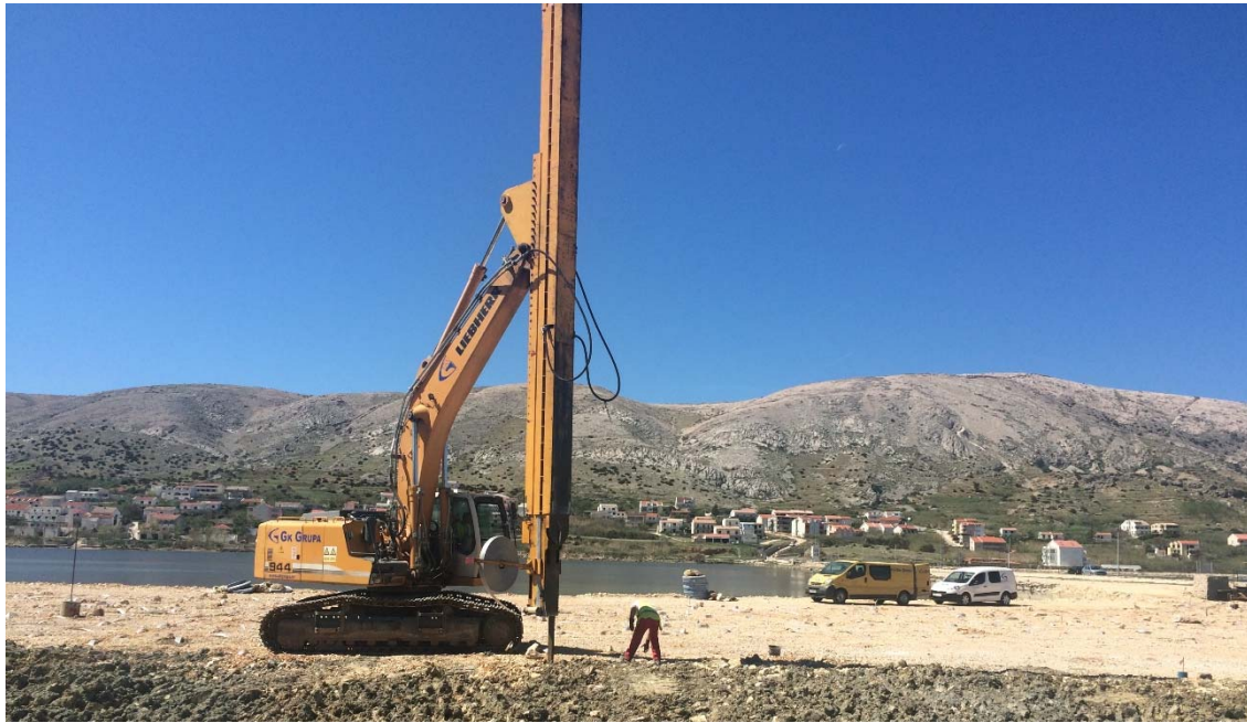
Einbau vorgefertigter vertikaler Streifendrains
