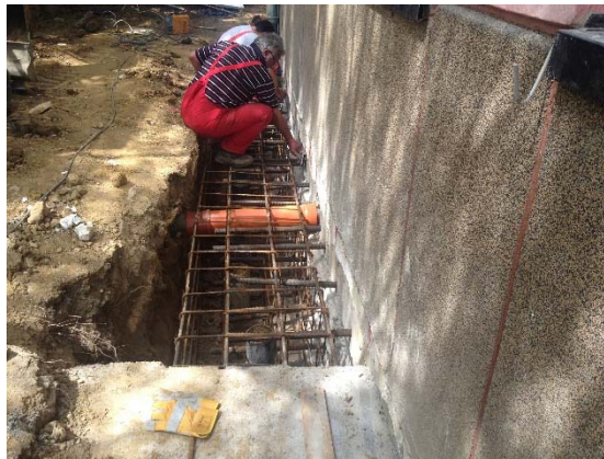
Bewehrung des Kopfbalkens
