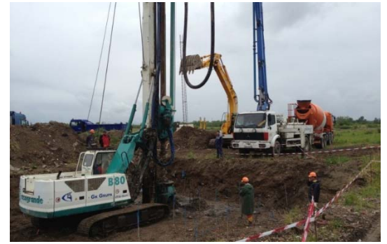
Ausführung SOB Pfähle
