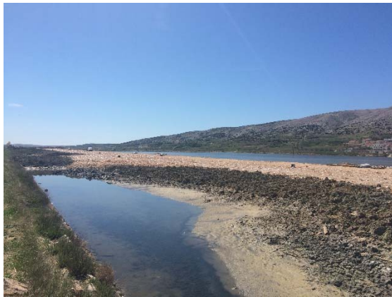
Dammschüttung im Meer
