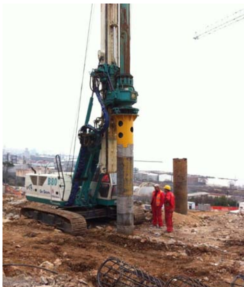
Pfahlbohrung mit Schutzrohren
