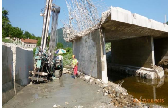
Jet Grouting neben dem Fluss
