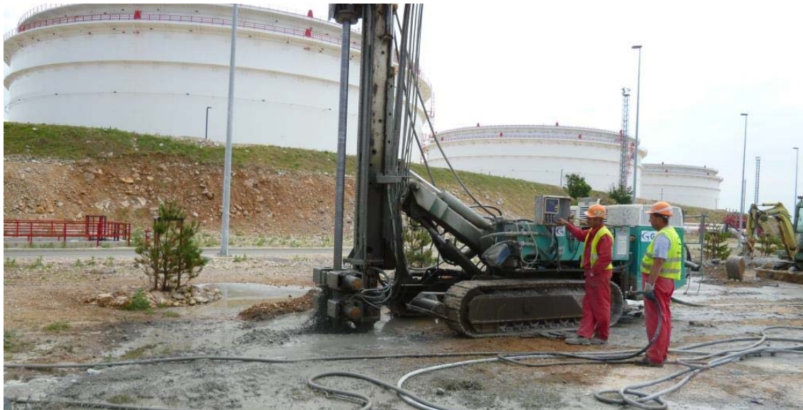
← Ausführung einer Jet Grouting Säule
