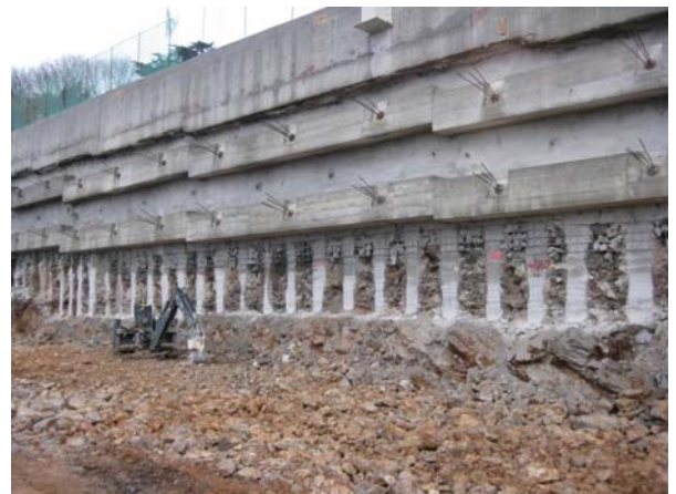
Vorbereitung der Pfahlwand für Ankereinbau und Spritzbeton
