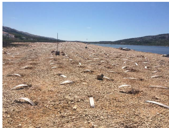
Ein Bereich ausgeführter vertikaler Streifendrains
