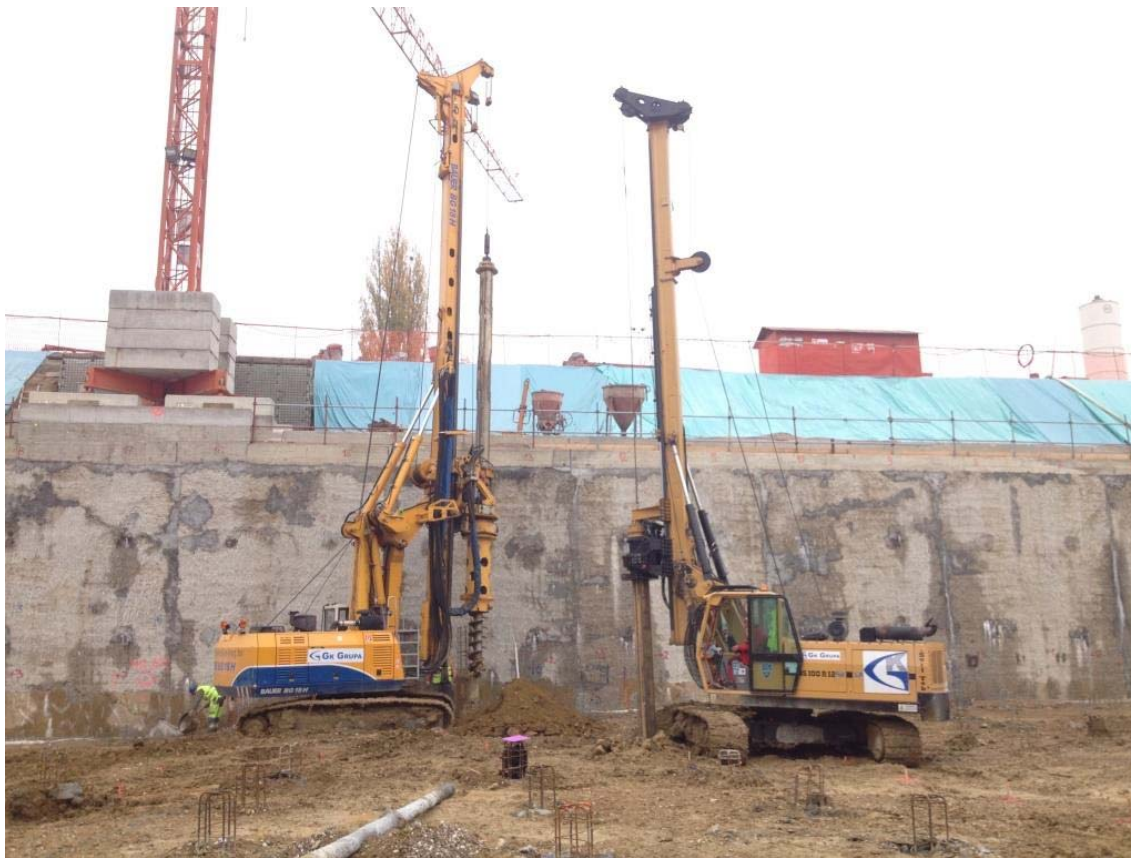
← Arbeit mit zwei Bohranlagen
