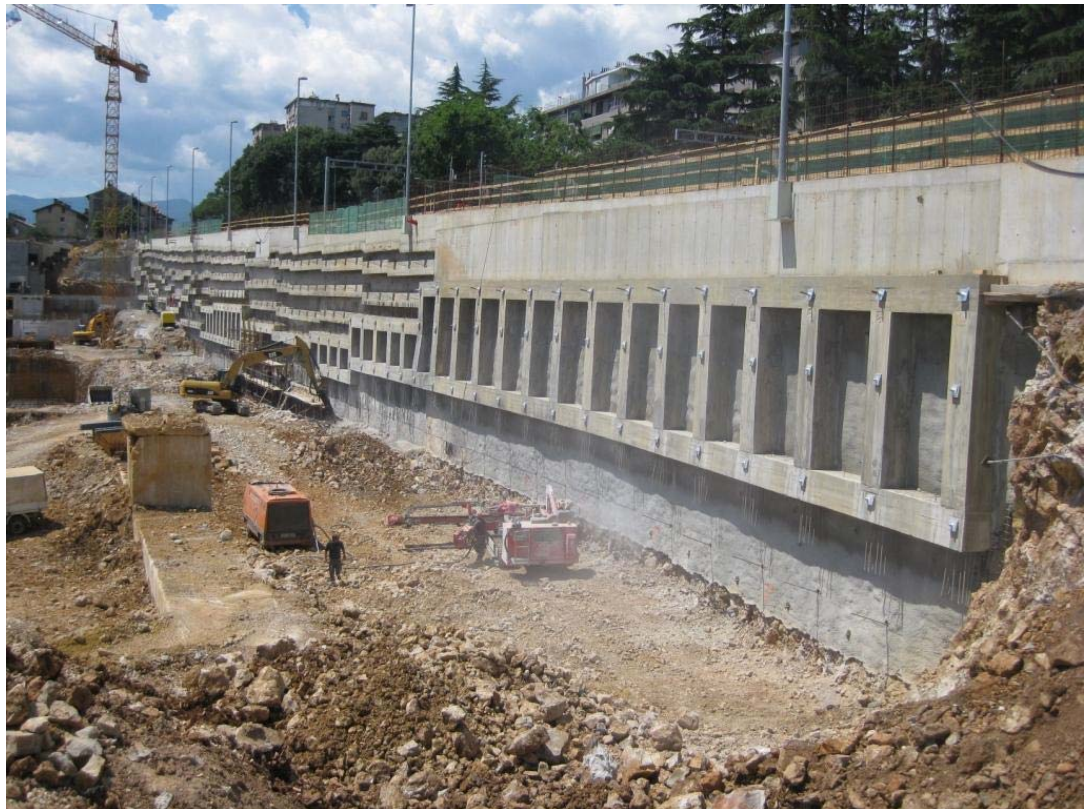
Stützwand Hauptstraße in Rijeka
