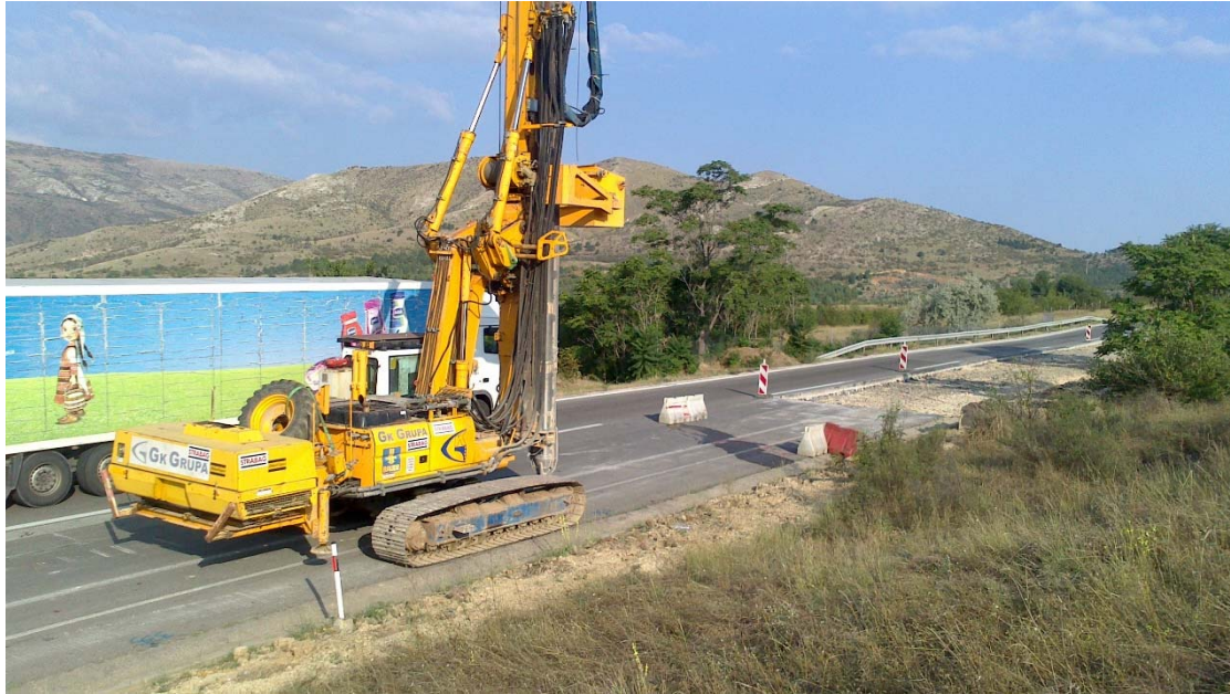
Ausführung der Schottersäulen auf der Autobahn
