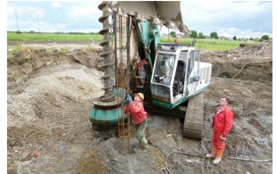
Einbau Pfahlbewehrung
