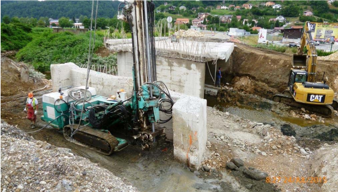
Jet Grouting direkt neben dem freigelegten Brückenwiderlager
