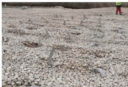
Vertikaldrains
