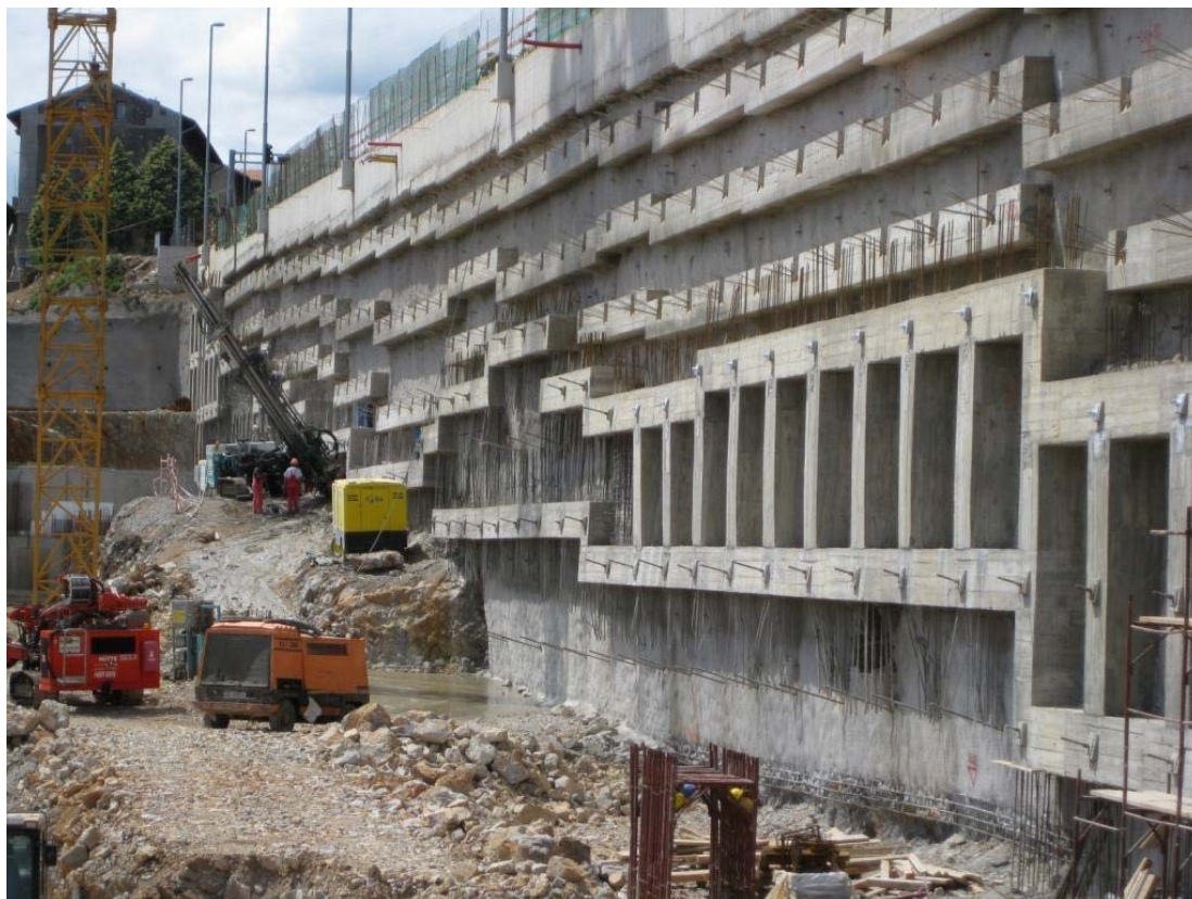
← Bodenverfestigung mit Jet Grouting hinter der Stützwand
