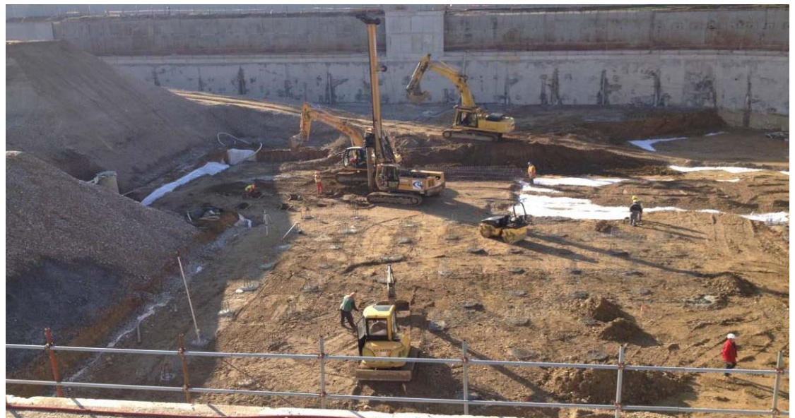
Bohrarbeiten in der Baugrube
