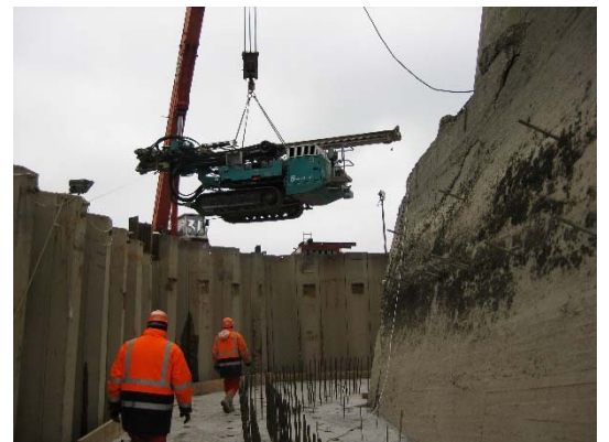
Transport des Bohrgeräts zum Pfeiler
