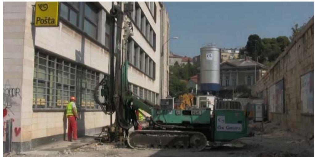
Ausführung Jet Grouting
