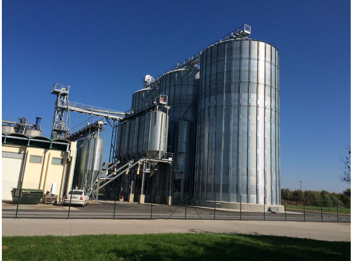
Getreidesilos in Betrieb
