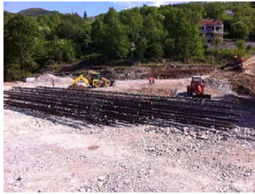
Bewehrungskörbe der Pfähle
