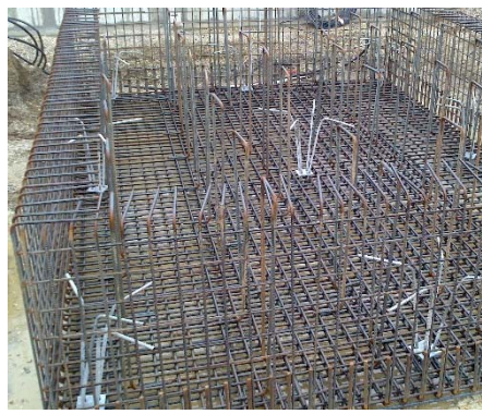
Bewehrung des Stützenfundamentes
