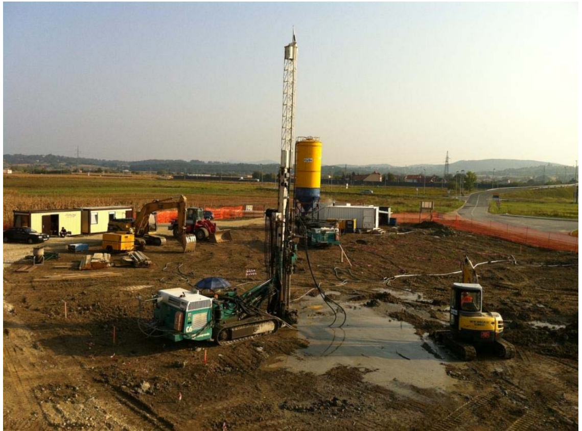
Jet Grouting - Beginn der Arbeiten
