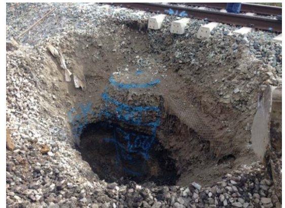
Kontrolle des erreichten Durchmessers
