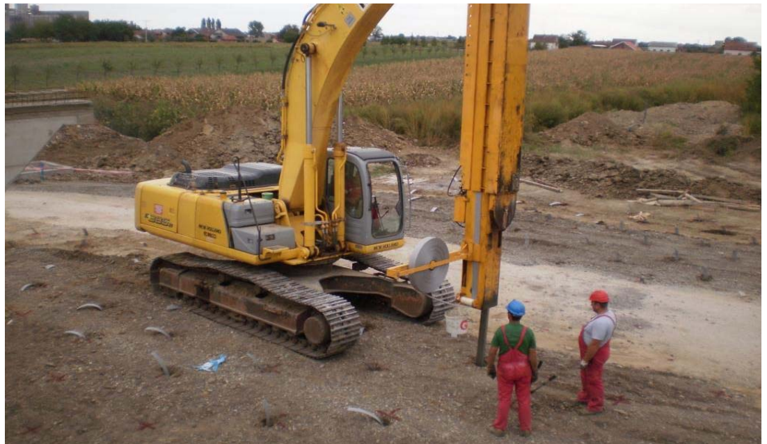
Ausführung Vertikaldrains
