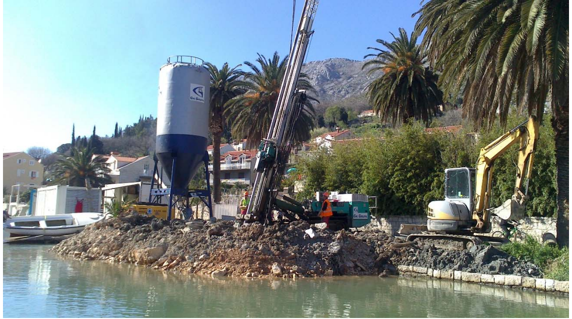
Baugrubensicherung am Ufer von Ombla
